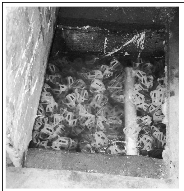
Figure 8-20: Plastic media AUF (Sasse, 1998)
